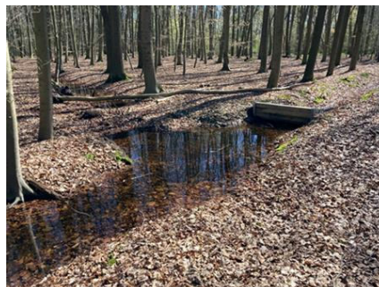
Erdstau- und Dammbalkenverschluss
