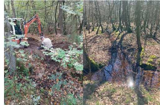
Holzstau mit dahinter liegendem Kleingewässer während und nach Umsetzung
