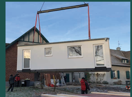
Montage des Neubaus in Modulbauweise
