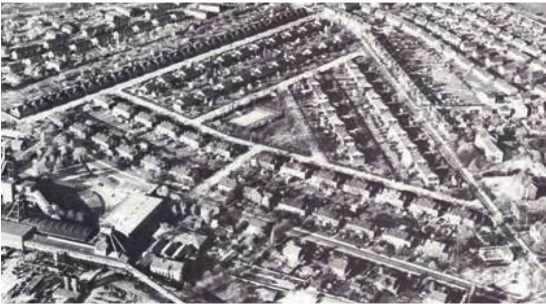
Luftbild Dreiecksiedlung; Quelle: Dortmunder Architekturhefte Nr. 11
