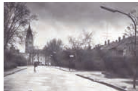
Straßenansicht Dreiecksiedlung; Quelle: Stadt Recklinghausen
